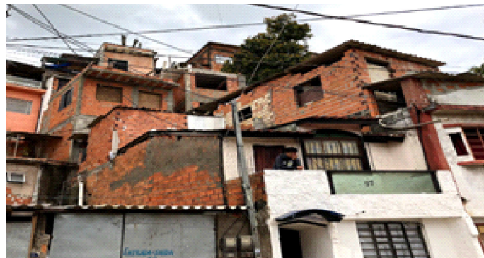
Figura 9 - Concentração de moradias cobrindo parte do talude na rua Progresso. Fonte: Equipe de pesquisa, 2019.
