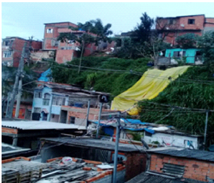
Figura 8 - Talude da Rua Progresso que sofreu escorregamento de terra em 25 de janeiro de 2019. Fonte: Equipe de pesquisa, 2019.
