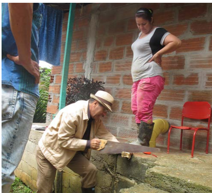
Figura 12: Entre las áreas de conocimiento del equipo de investigación se incluía la experiencia profesional en técnicas de construcción, que se puso a disposición de los residentes. Aquí uno de los profesionales del equipo muestra los principios de cómo preparar la formaleta en madera antes de llevar el concreto. Fuente: Equipo de Investigación.
