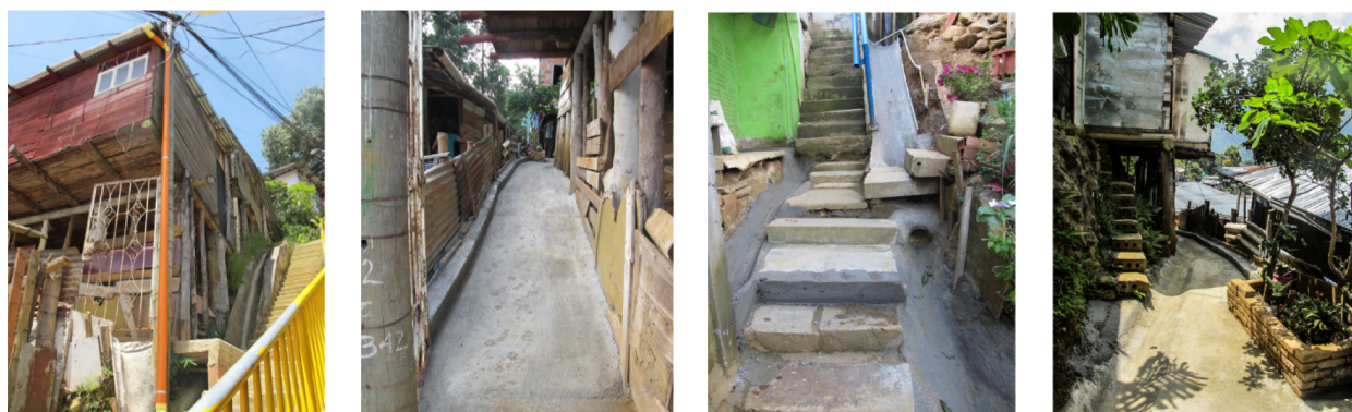
Figura 13. Obras menores para conducción de aguas, ejecutadas por convite en Pinares de Oriente en 2017. A. Canoa y bajante de agua lluvia; B. Entrada servidumbre; C. Cañuela en servidumbre; D. Piso duro en servidumbre. Fuente: Equipo de Investigación.
