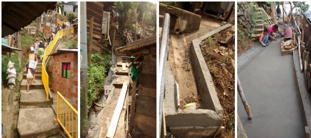
Obras ejecutadas por convite en Pinares de Oriente en 2017. Figuras 9 y 10. Cañuelas de bajo costo en construcción en Pinares de Oriente. Figuras 11 y 12. Obras de conducción de aguas lluvias en Pinares de Oriente. Fuente: Equipo de Investigación.
